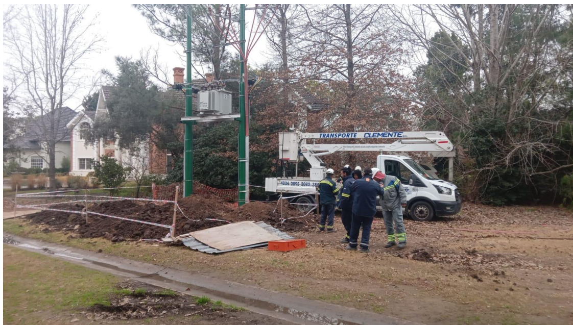
Trabajos de conexión y empalme en Las Magnolias · 2024.
