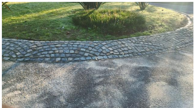
DESPUÉS · Adoquines y borde recuperados.
