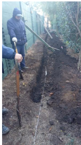
Trabajos de canalización realizados hasta 2023.
