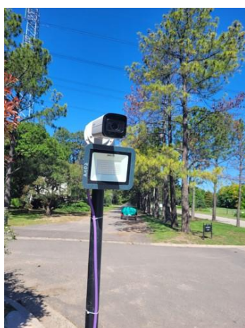
Equipo de cámara en el sector de acceso.
