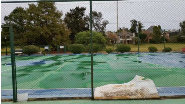
ANTES · Superficie y cerramientos previos a la intervención.
