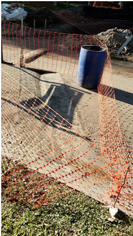
Captación y trabajos del sistema de Araucarias.
