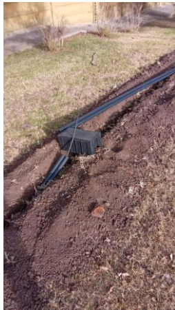
OBRA · Canalización y caja de inspección · 2022.
