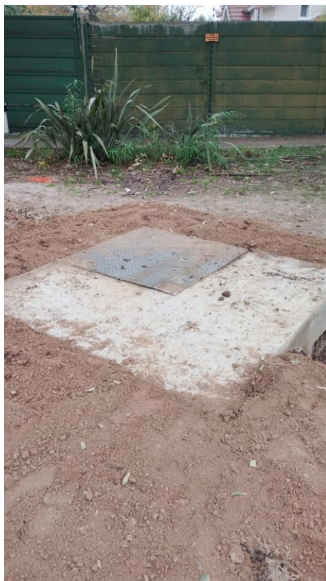
Cámara con tapa y boca de inspección, al completar la obra civil.
