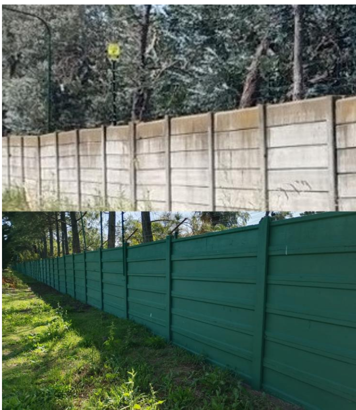
ANTES Y DESPUÉS · Conservación del muro perimetral.
