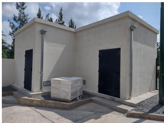
Edificio del depósito · 2021.
