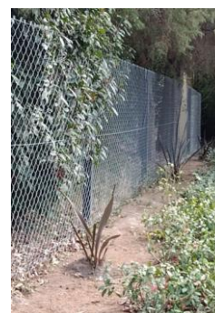
Cerco lateral para delimitar el sector próximo al recorrido peatonal.
