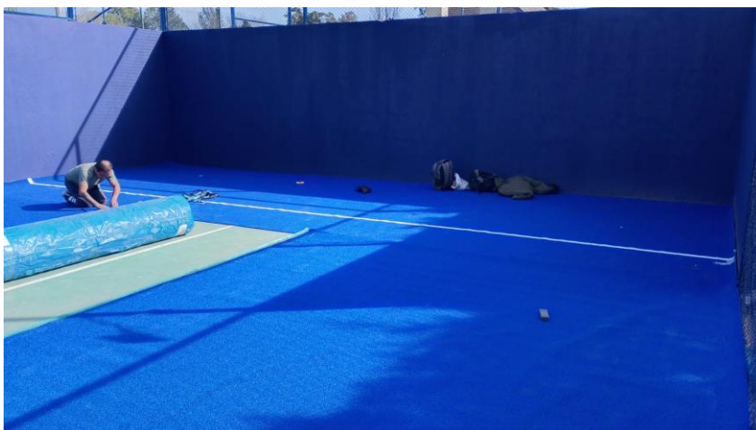
PROCESO · Colocación de la nueva superficie durante la obra de pádel.
