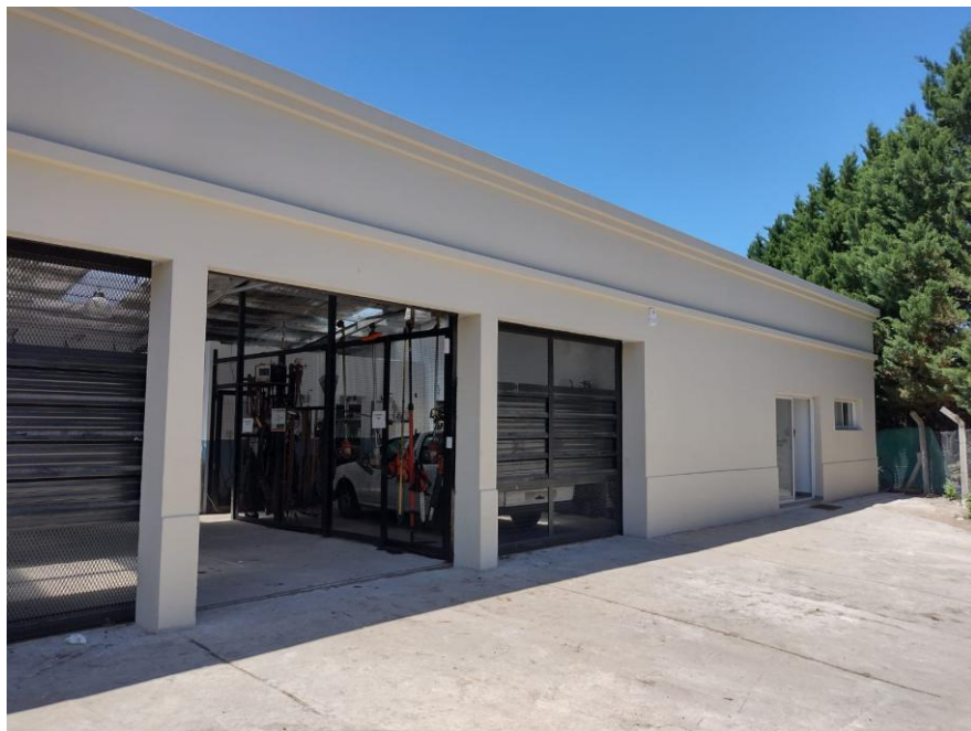
Sector de mantenimiento terminado · 2021. El edificio reúne guardado de máquinas y materiales y espacios de trabajo.
