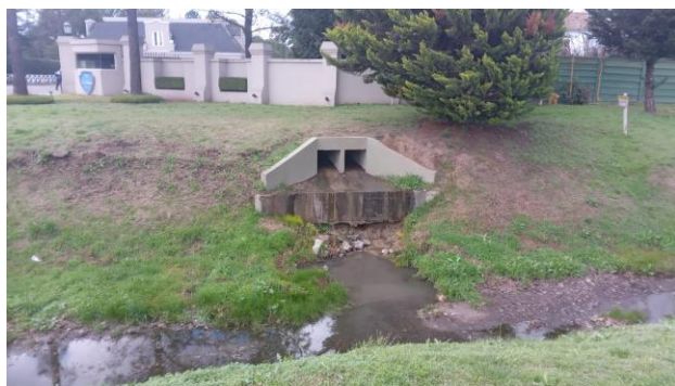
ETAPA ANTERIOR · Desagüe antes de los trabajos de pintura posteriores.
