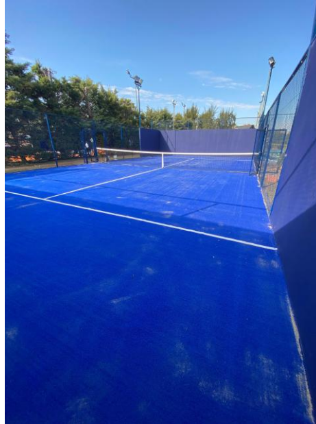
DESPUÉS · Cancha con la superficie azul renovada. Las tomas muestran el mismo tipo de instalación desde encuadres diferentes.
