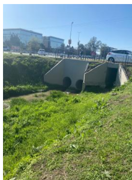
RESULTADO · Sector de desagüe conservado y pintado.
