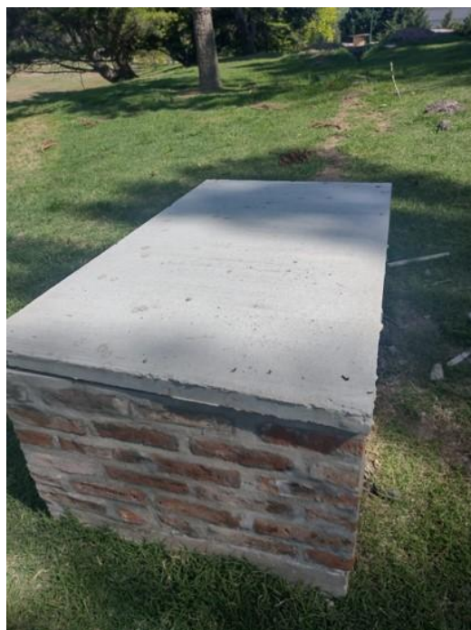
Vista exterior de la instalación de abastecimiento.
