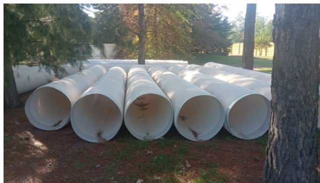
Conductos acopiados para la nueva conducción de la segunda etapa.
