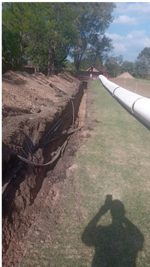
Zanjeo y preparación del tendido hacia el sector de descarga.
