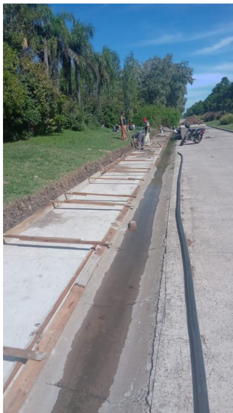
Nuevo badén de hormigón durante los trabajos.
