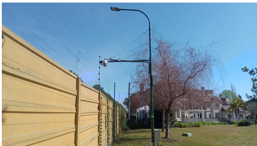
Columnas, iluminación y cámaras trabajando sobre un mismo recorrido perimetral · 2022.
