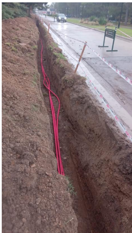
Cableado de media tensión durante la ejecución. Las fotografías permiten ver el recorrido antes de su cobertura.
