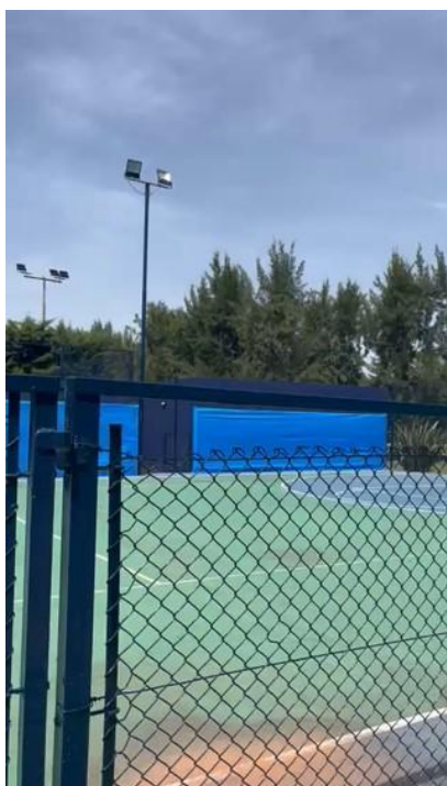
Cerramiento del polideportivo.
