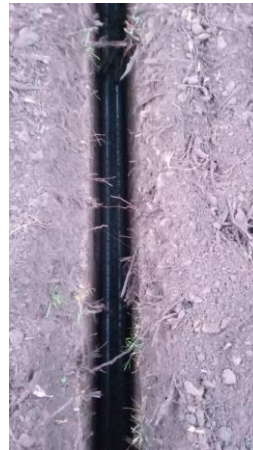
OBRA · Ductos colocados antes de cerrar la zanja · 2022.
