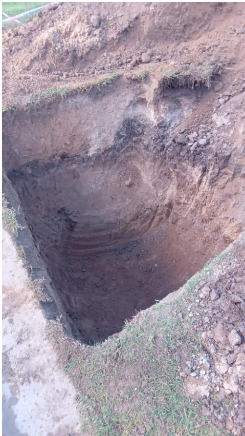
Cateos y canalizaciones: apertura para reconocer el terreno y preparar los recorridos.
