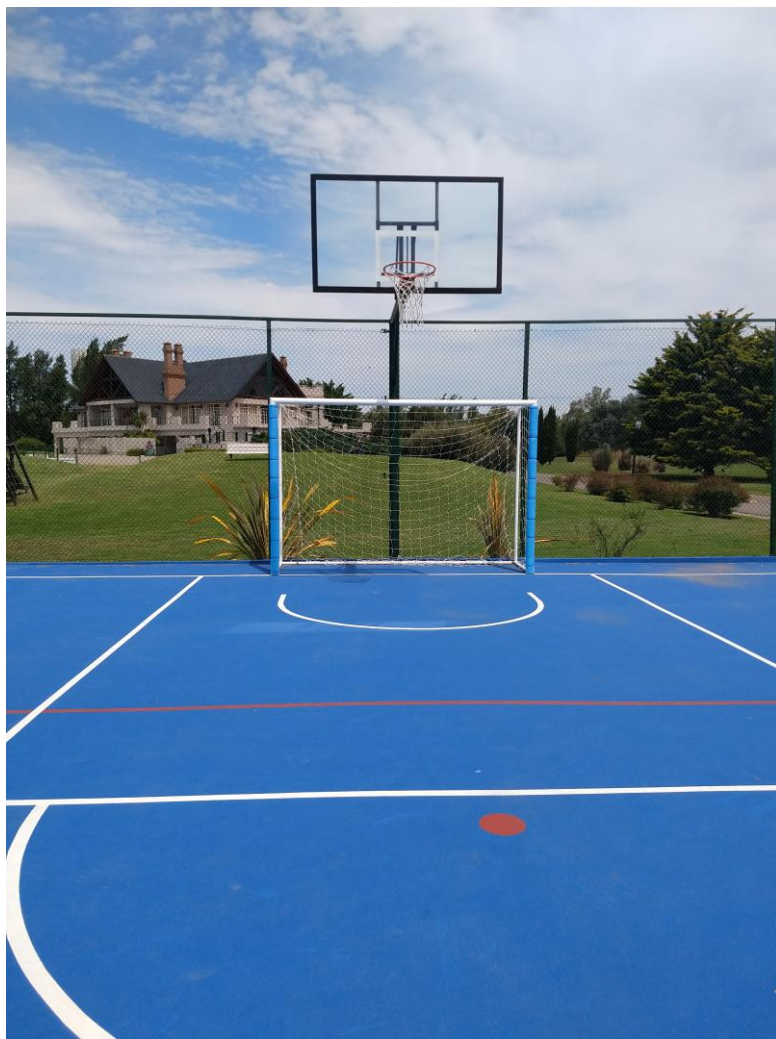
Polideportivo · 2018. Se reconocen las demarcaciones y el equipamiento de la nueva superficie.
