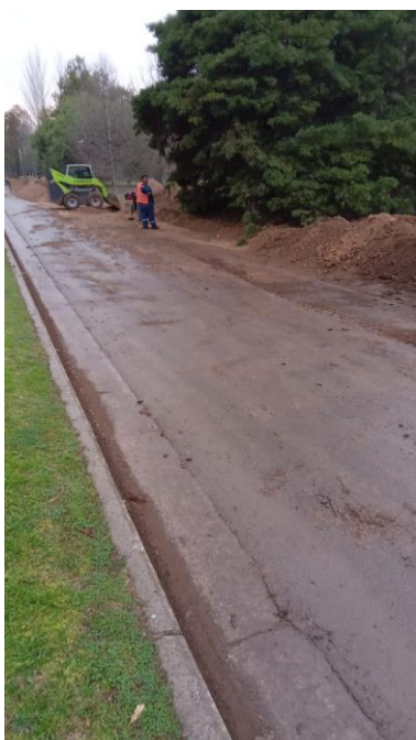
Cobertura del tendido en el Boulevard durante los trabajos.
