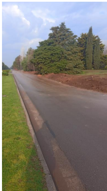
Sector del Boulevard luego de la cobertura y limpieza de los trabajos.
