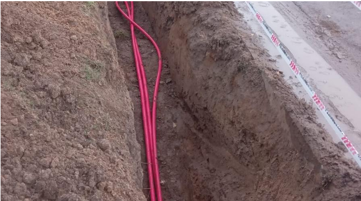
Tendido subterráneo durante la ejecución de la obra eléctrica.
