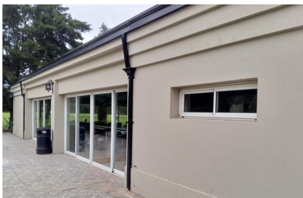
Vista de la fachada renovada.
