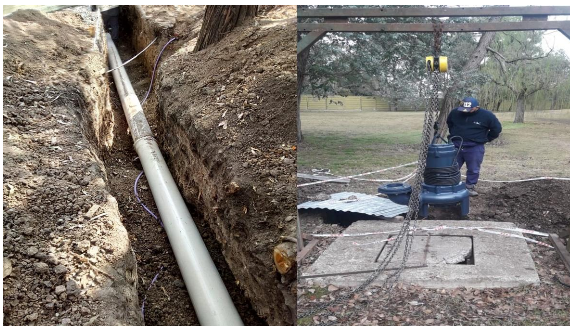
Conducción enterrada y trabajos de bombeo · 2020.
