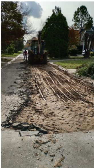
DURANTE · Retiro del pavimento deteriorado.
