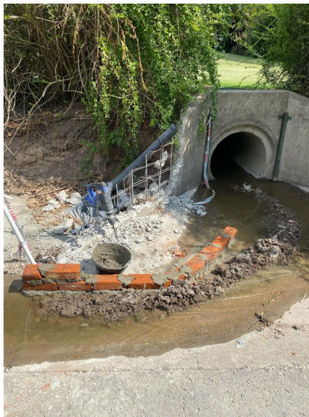
Entrada del conducto de 800 mm, con adecuaciones de las aletas colectoras.
