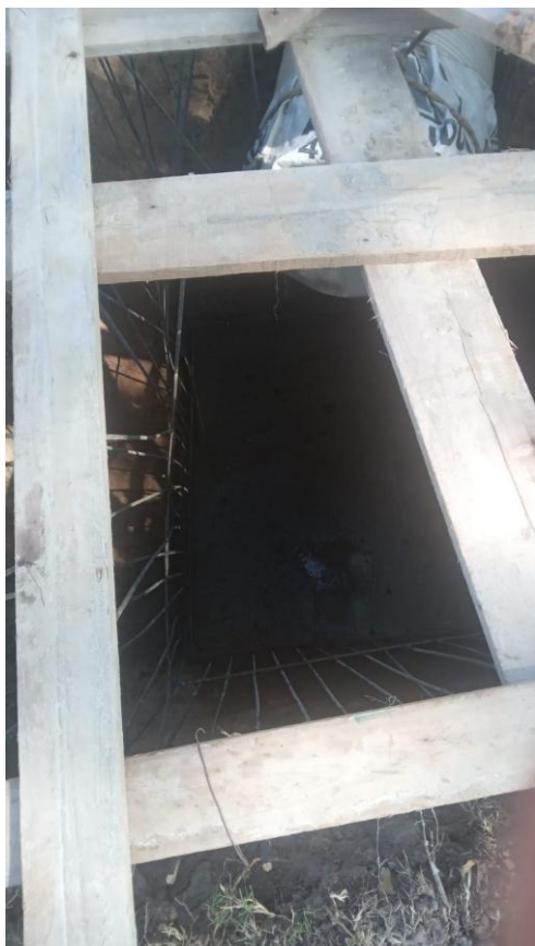
Construcción de la cámara de impulsión: estructura y obra civil.
