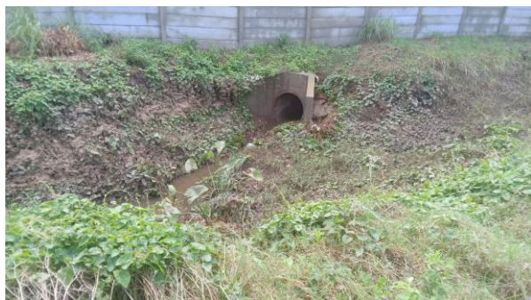
ANTES · Estado del zanjón · 2024.
