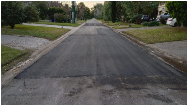
DESPUÉS · Pavimento reparado.
