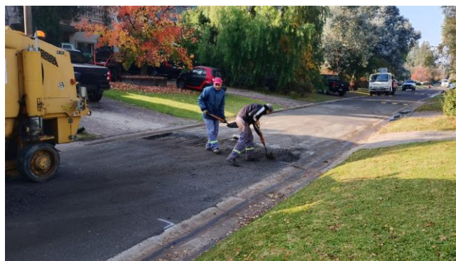
Trabajos de colocación de asfalto.
