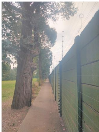
Sistema detector sobre el muro.
