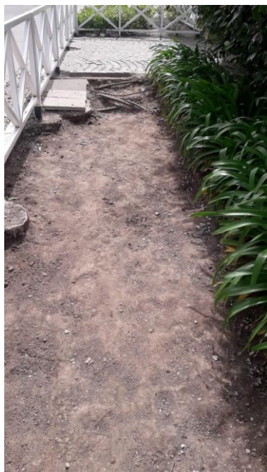
PROCESO · Trabajos de vereda y recorrido peatonal.
