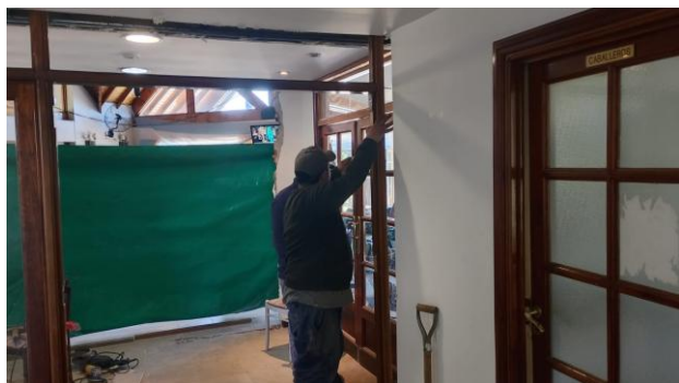
PROCESO · Trabajos durante la reconversión del espacio.
