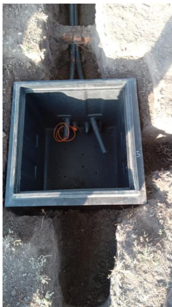
Nueva caja y recorrido de fibra en el perímetro de Ruta 52.
