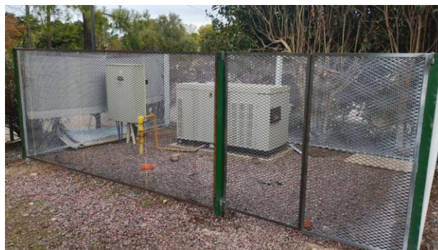
Ampliación del cerramiento del sector realizada en 2026 por personal propio.
