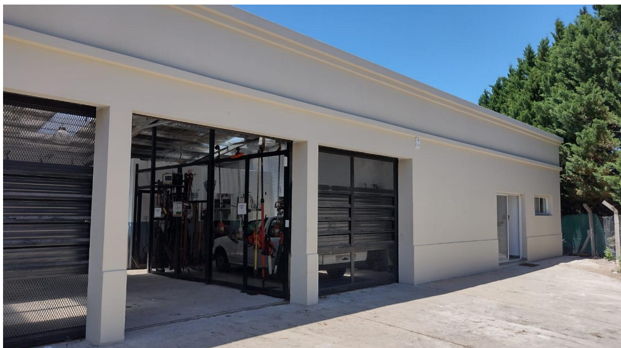
Edificio del sector de mantenimiento · 2021.
