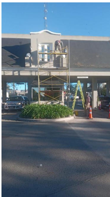
Trabajos de pintura y reparación del edificio de Portería vehicular.
