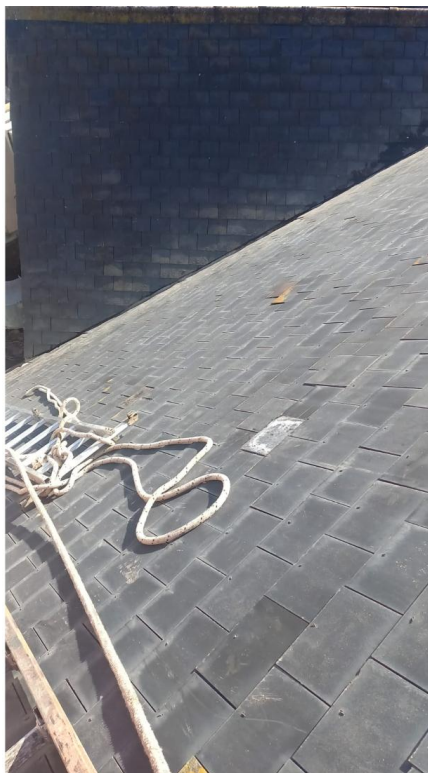
RESULTADO · Vista de la cubierta, hasta 2025.
