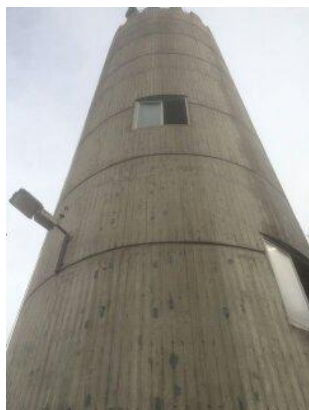
Tanque de reserva · trabajos de reparación.
