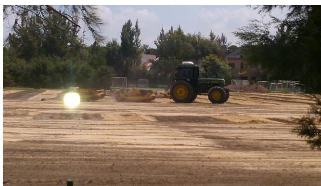
Movimiento y preparación del suelo durante la reconstrucción.
