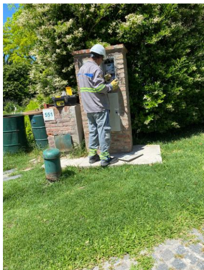
Trabajo de conexión en un pilar de vivienda.
