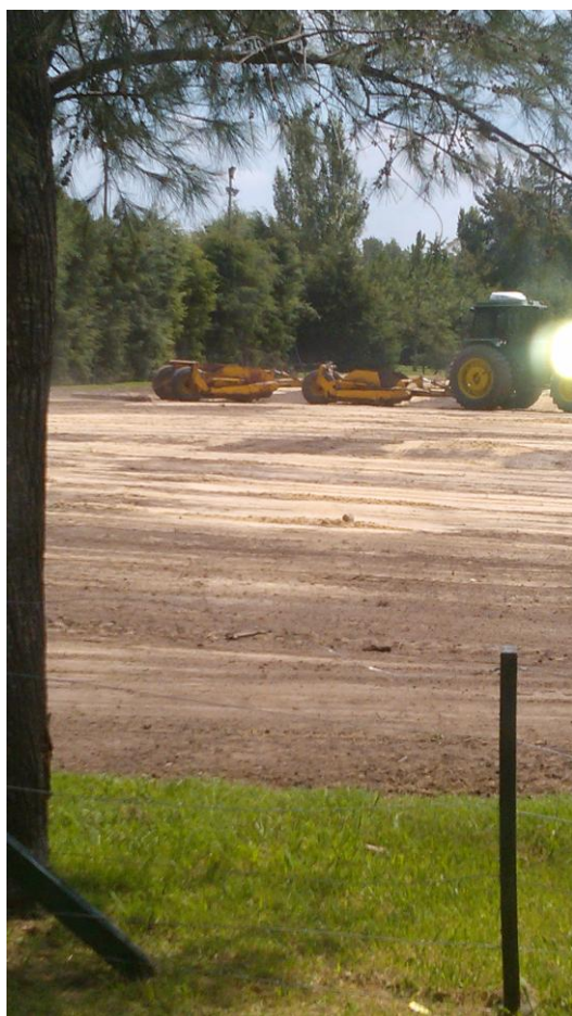
Obra sobre la cancha · febrero de 2016.
