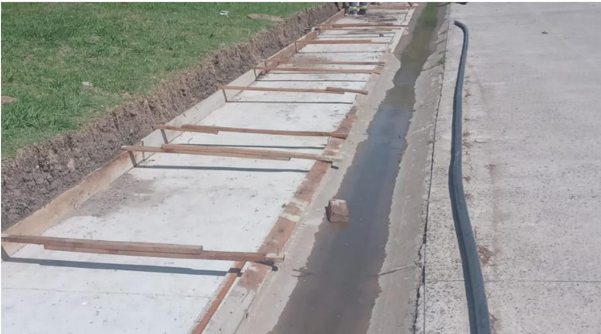
Obras de conducción y desagüe de Cinco Esquinas.
