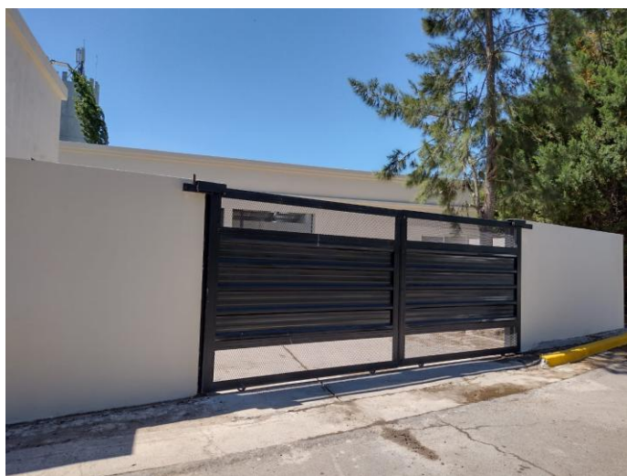
Cerramientos y acceso del sector de mantenimiento · 2021.
