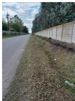
DESPUÉS · Sector despejado después de los trabajos de limpieza.
