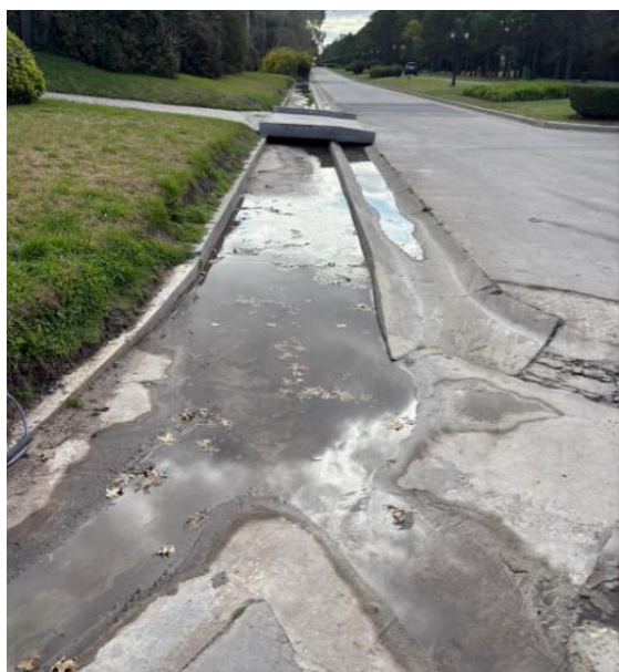
Badén ampliado: parte visible del nuevo recorrido de evacuación.
