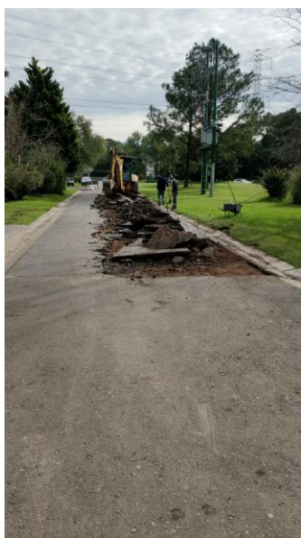
Demolición y retiro de material.
