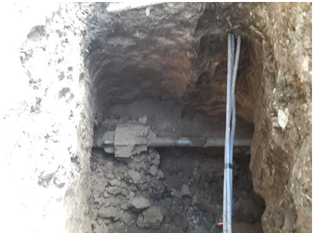
Paso subterráneo realizado con tunelera.
